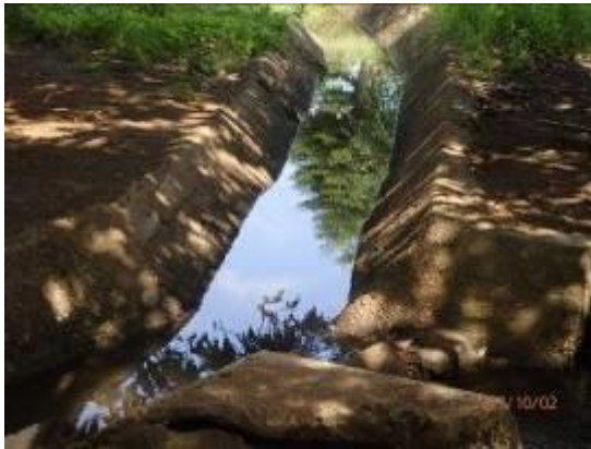
Amenée d'eau par le canal depuis Tantigou
