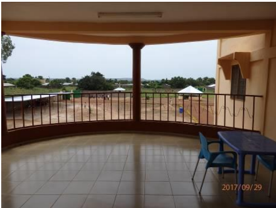
Terrasse de repos au 1 er étage du centre de soins
